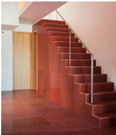
Pavimentos interiores de baldosas y escaleras de piedra natural
